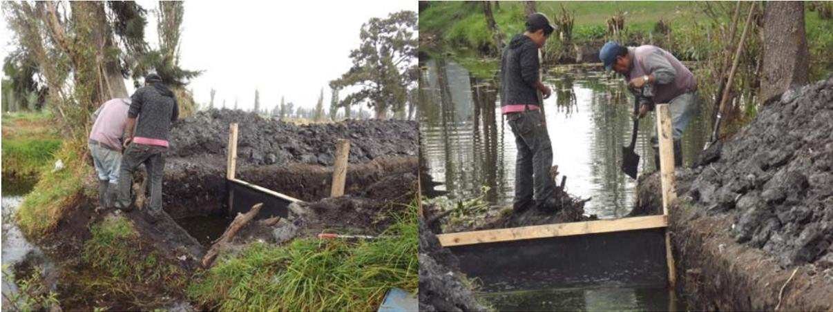
Figura 43. Colocación de compuertas en zanja y retiro de bordo en la chinampa del Sr. Eduardo Rivera.
