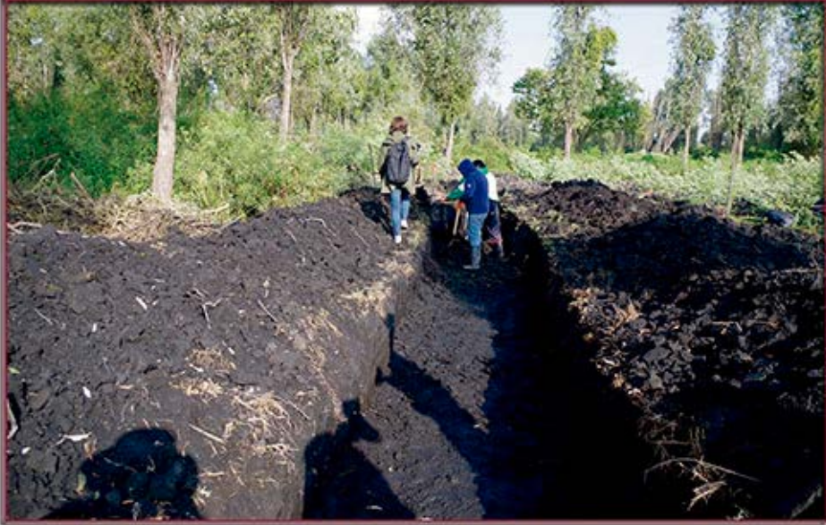
Figura 19. Apertura de un canal
