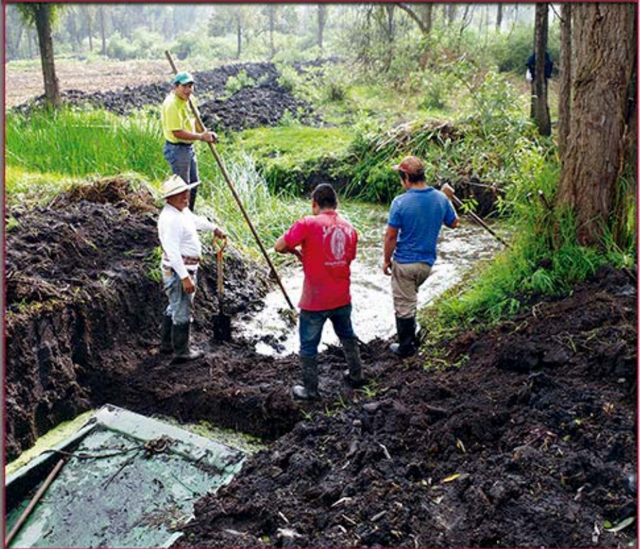
Figura 21. Pedro Méndez y su equipo construyendo un tapón
