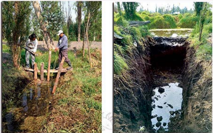
Figura 17. Javier y Marco del Valle construyendo barrera para refugio
