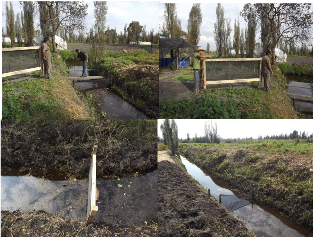
Figura 179. Instalación de compuertas en la zanja de 107 m (arriba, compuerta sur; abajo izquierda, compuerta norte; abajo derecha, división con malla sombra).
