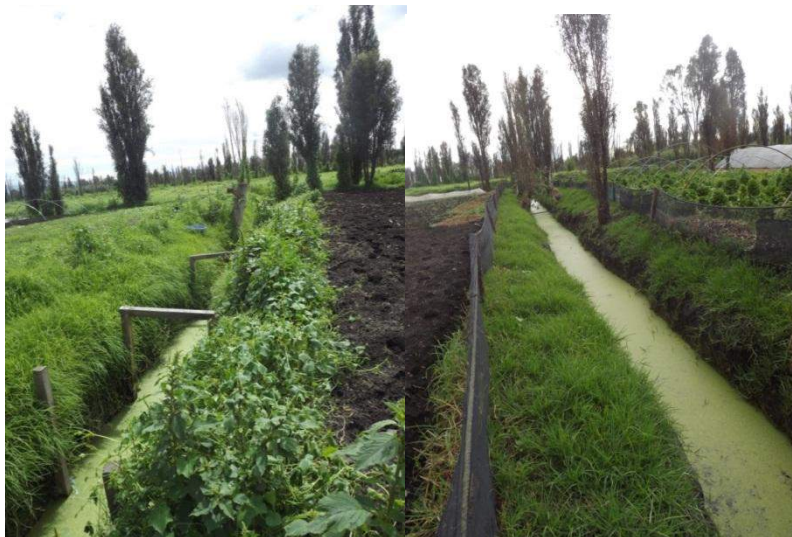
Figura 171. Zanjas de 45 m (izq.) y de 40 m (der.) en la chinampa del Sr. Santana, habilitadas en 2009 y 2010.
