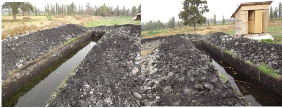
Figura 162. Zanjas en la chinampa del Sr. Eduardo Rivera. A la izquierda la zanja de 33 m y a la derecha la zanja de 18 m.
