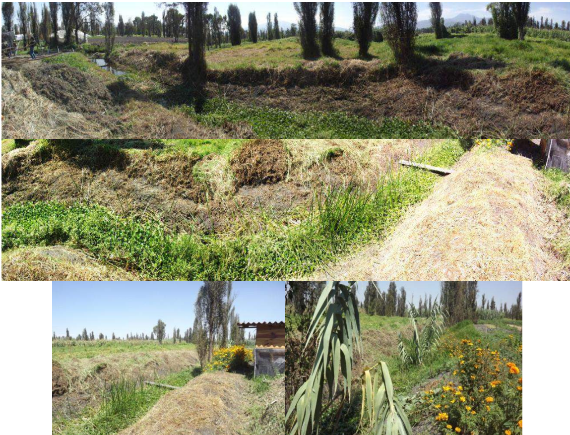
Figura 177. Limpieza paulatina de la zanja, imágenes del 21 de octubre.
