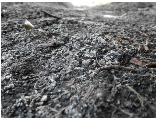
Figura 106. Aspecto de suelo con problemas de salitre.
