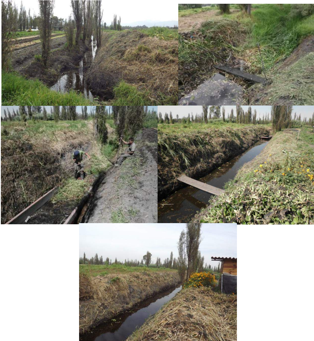
Figura 178. Zanja del Sr. Santana, libre de vegetación.
