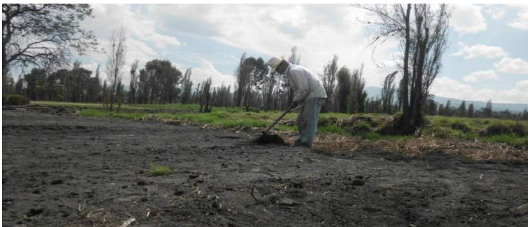
Figura 97. Trabajos de nivelación de chinampa.
