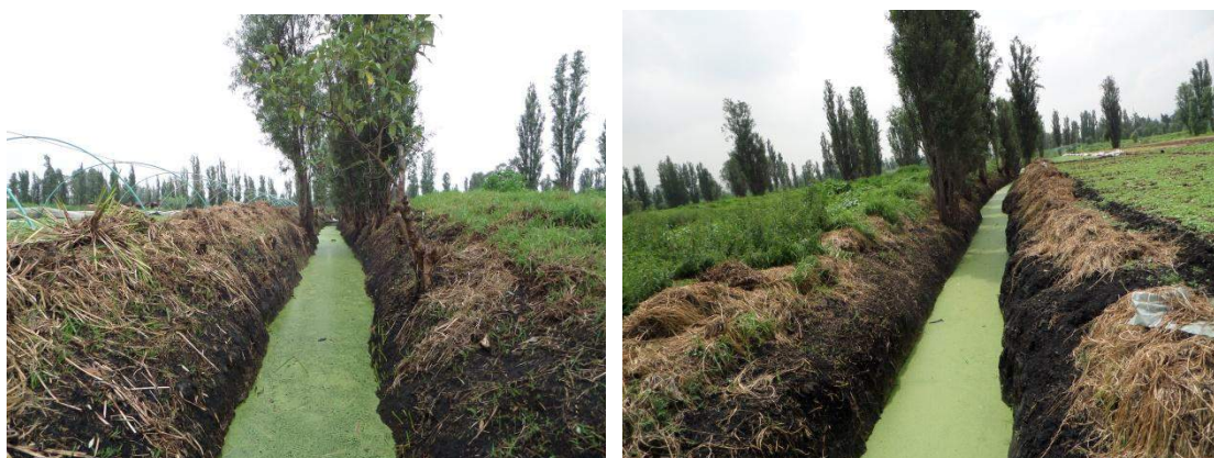
Figura 32. Rehabilitación de la zanja “Laguna de Tlicuili”.
