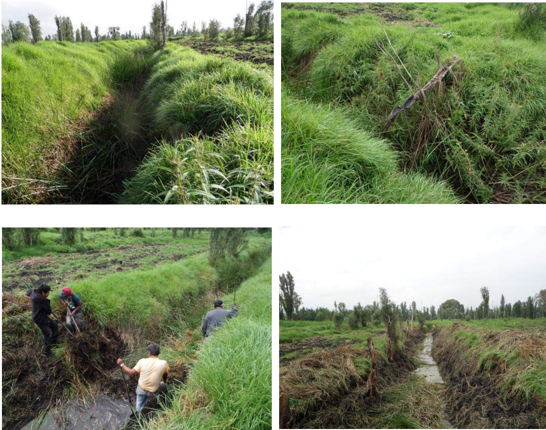
Figura 30. Rehabilitación de la zanja “Paso del Águila”.
